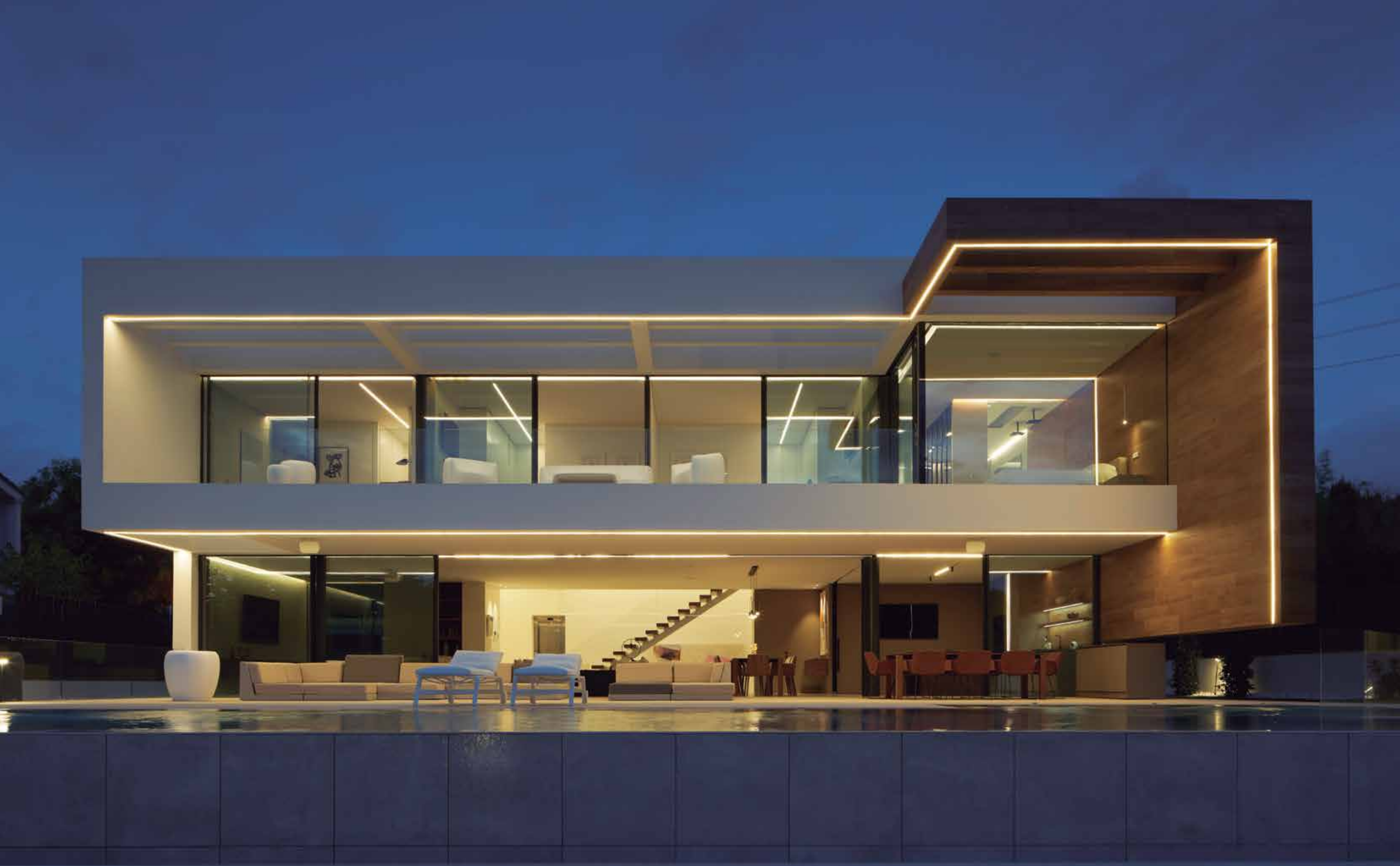
JISO Iluminación | PROJECT | Residential Doblesee Studio . Spain
